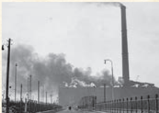
Snímek zachycuje okamžik, kdy byl v průběhu roku 1966 postupně přepojován odvod spalin na vysoký komín.
