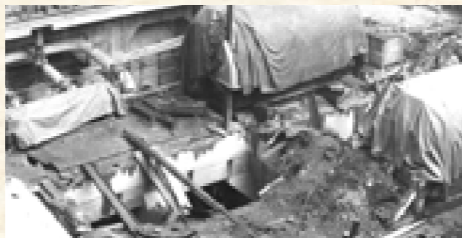
Kvůli množství popílku se v roce 1960 propadla střecha strojovny.
