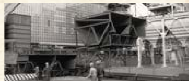
V 90. letech minulého století proběhla velká ekologizace teplárny, na fotografii montáž fluidního lože kotle.
